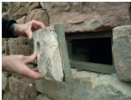
Pierre plate collée sur le cadre en bois et percée d'un trou d'envol
