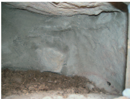
Cavité colmatée avec du mortier et garnie de sciure et de terreau
