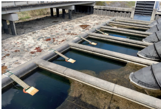
Après la pose de rampes (photo M. Bury)
