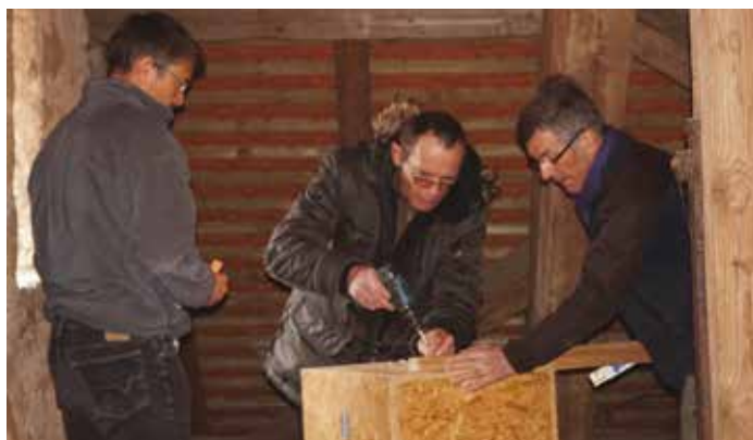
Installation d'un nichoir à effraie à Aschbach (photo Frédérique Merck)
