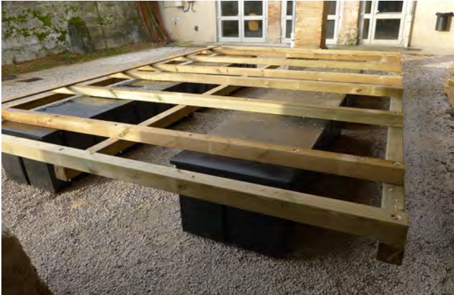
Radeau avec flotteur en polyéthylène et structure en bois en cours de réalisation / Floß mit den Schwimmkörpern aus Polyethylen und der darauf sitzenden Holzkonstruktion während des Zusammenbaus [Photo: © LPO Alsace]
