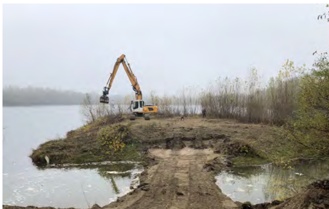
Défrichage de l'île existante sur le Wörthfeldsee près de Rastatt Plittersdorf / Rodung der bestehenden Insel auf dem Wörthfeldsee bei Rastatt Plittersdorf [Photo: © Volker Späth]
