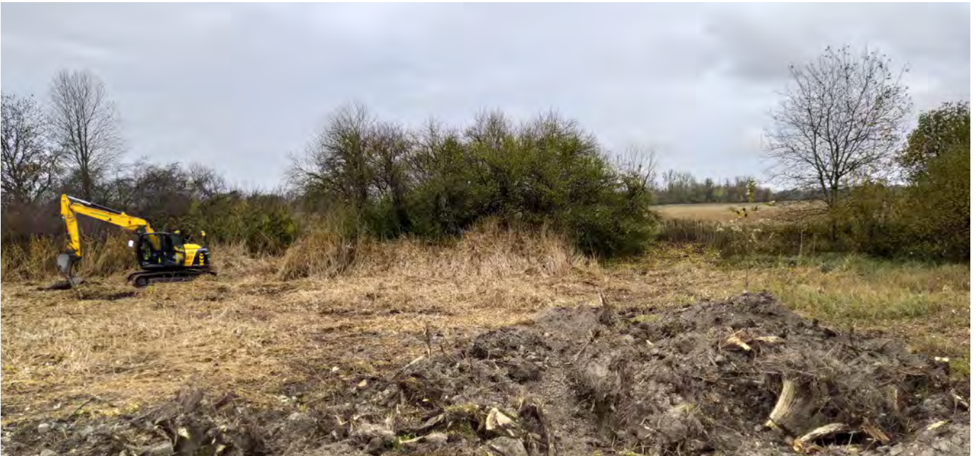
Travaux de renaturation en cours et retournement des troncs coupés / Laufende Renaturierungsarbeiten und Umdrehen der gefällten Stämme [Photo: © Alexandre Gonçalves]
