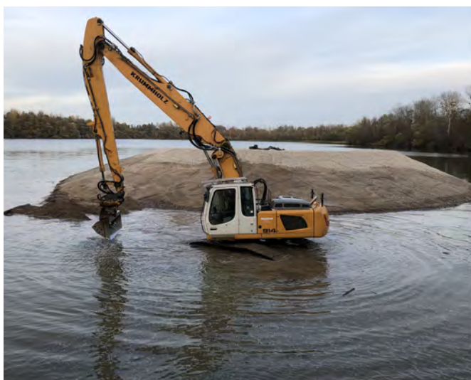
Démolition de la voie d'accès à l'île / Rückbau der Zuwegung zur Insel [Photo: © Volker Späth]
