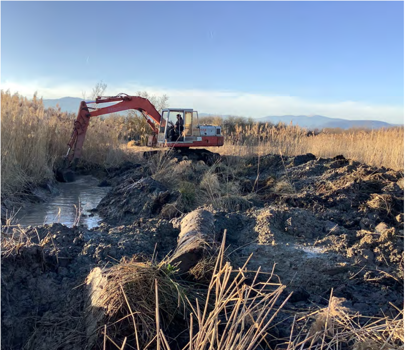
Travaux de creusement en cours de réalisation / Baggerarbeiten während der Umsetzung der Maßnahme [Photo: © François Kiesler]
