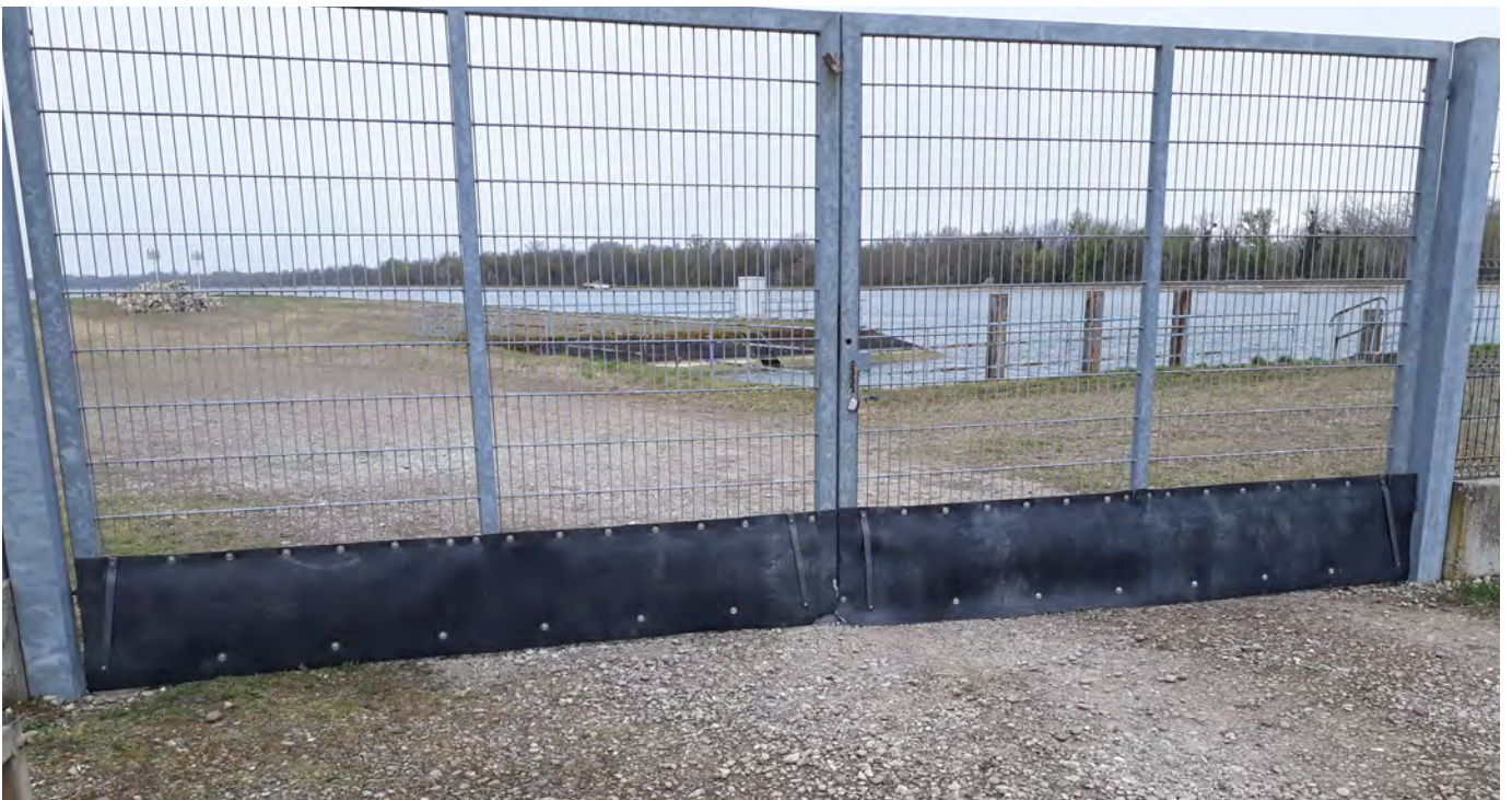
Reprise des zones non étanches aux prédateurs à la base du portail d'accès au musoir. / Nachbesserung der nicht raubtiersicheren Bereiche am Fuße des Zugangstors zum Brutplatz auf der Mole. [Photo: © Alexandre Gonçalves]
