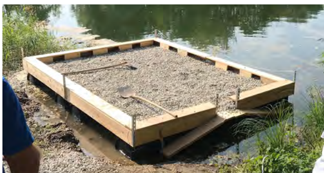
Radeau terminé, recouvert d'une couche de gravier et équipé d'une rampe d'accès / Fertiges Floß mit einer Schicht Kies und einer Rampe [Photo: © ILN Bühl]
