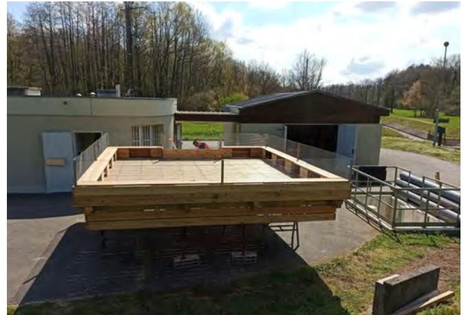
Radeau en cours de réparation. / Ein Brutfloß, das gerade repariert wird. [Photo: © Marc Keller]
