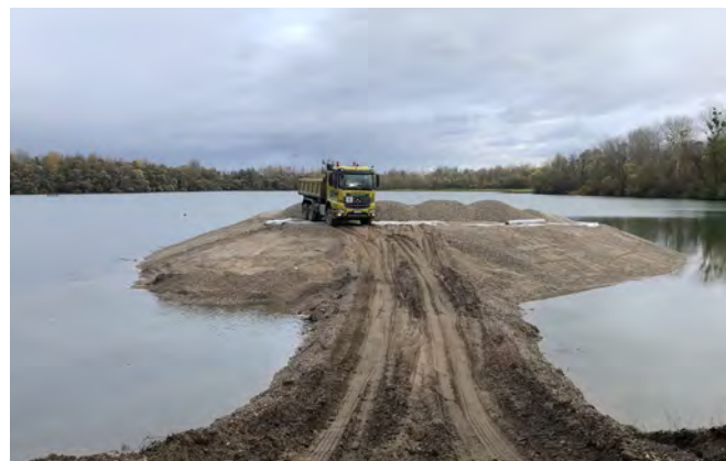
Application d'un géotextile non tissé puis d'une couche de gravier sur l'île nouvellement remodelée / Aufbringen eines geotextilen Vlies und einer neuen Kiesschicht auf umgestaltete Insel [Photo: © Volker Späth]
